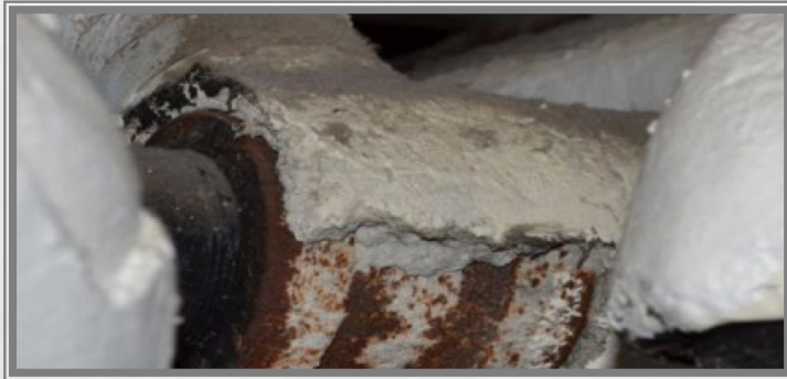
FRIABLE ASBESTOS
